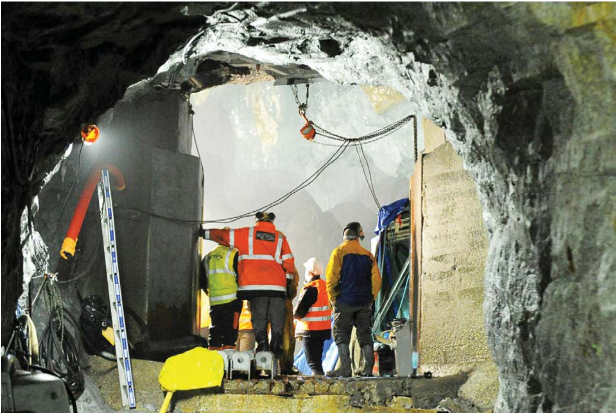
عمال على حافة مخزونات مياه تحت محطة شركة إي.دي.أف في شامونيه شرق فرنسا، التي تنتج الكهرباء من مياه أكبر كتلة جليدية في فرنسا
