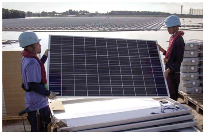
تعالوا واستكشفوا تجربة تركيب الألواح الشمسية
