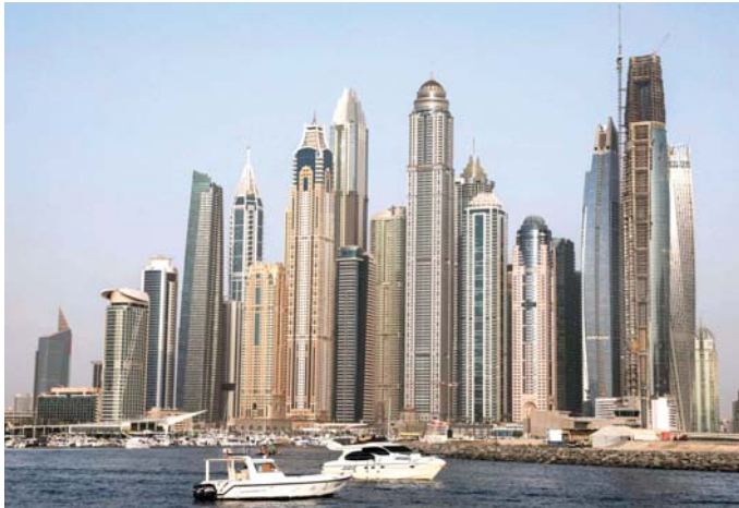
مركز للسياحة والأعمال في المنطقة
