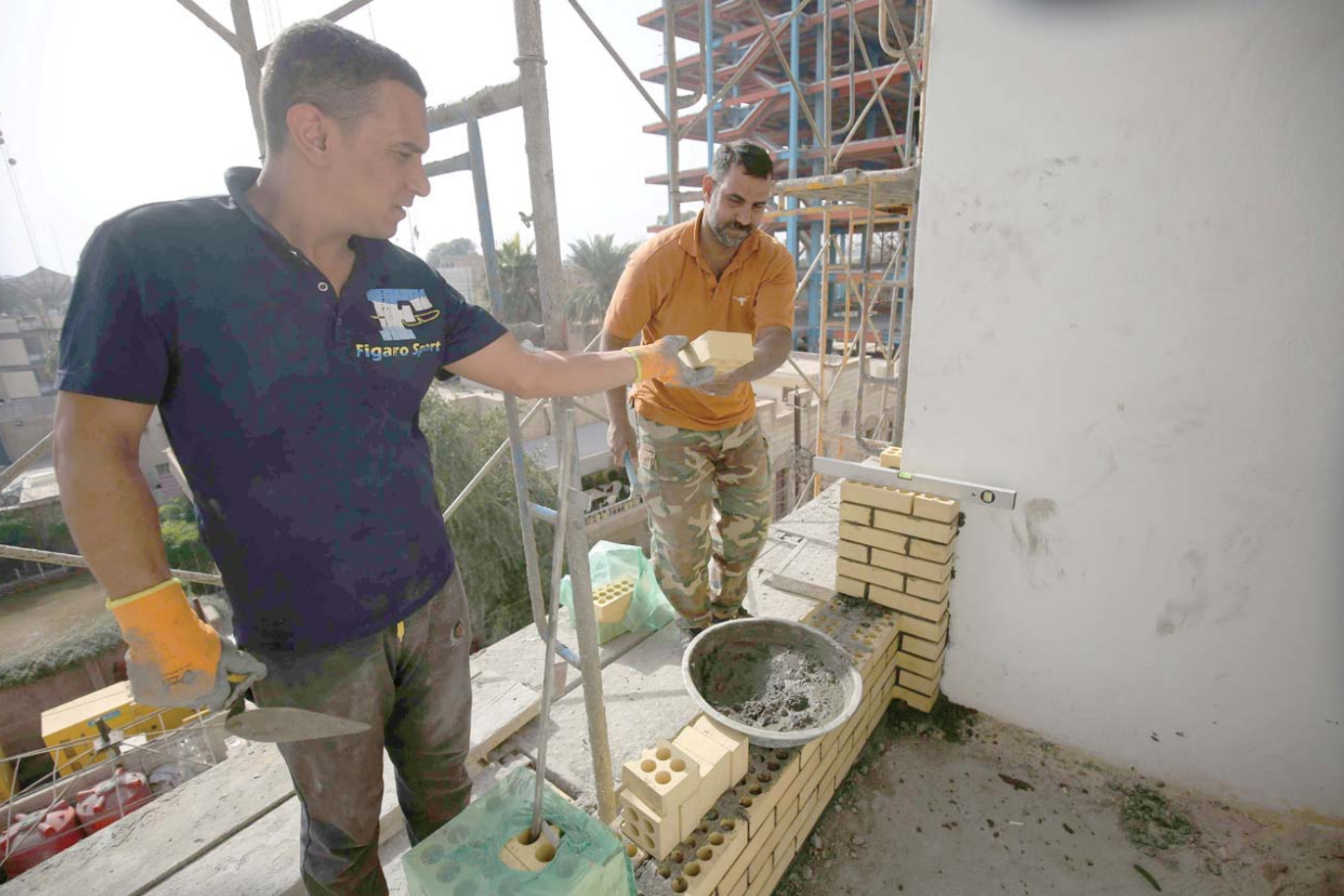
رصف الطابوق لبناء الجدار كما طلب المهندس
