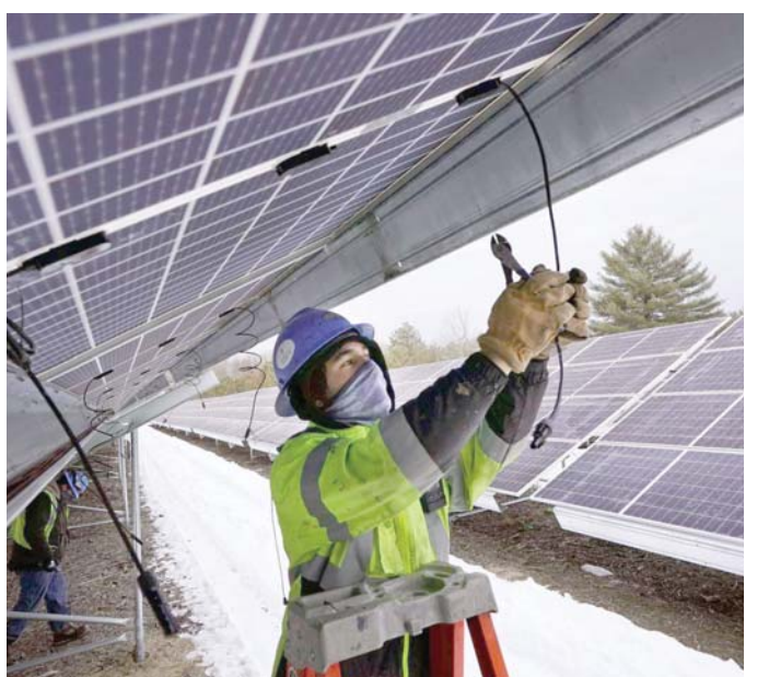
عملية صيانة بسيطة قبل تشغيل المحطة
