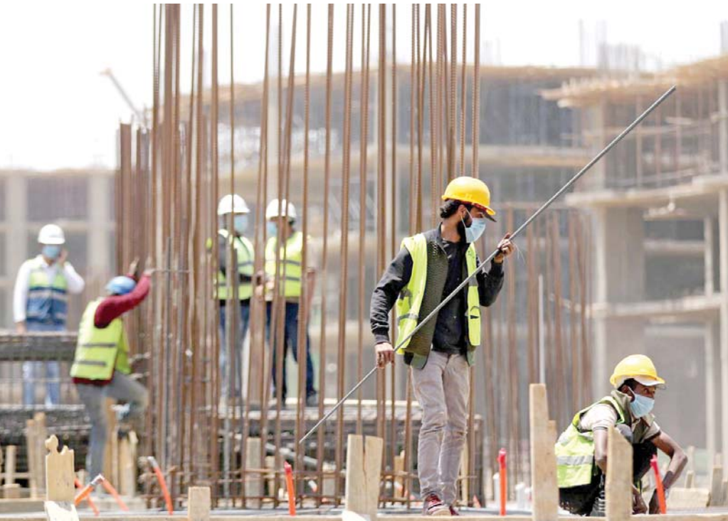
متابعة لصيقة لأعمال البناء
