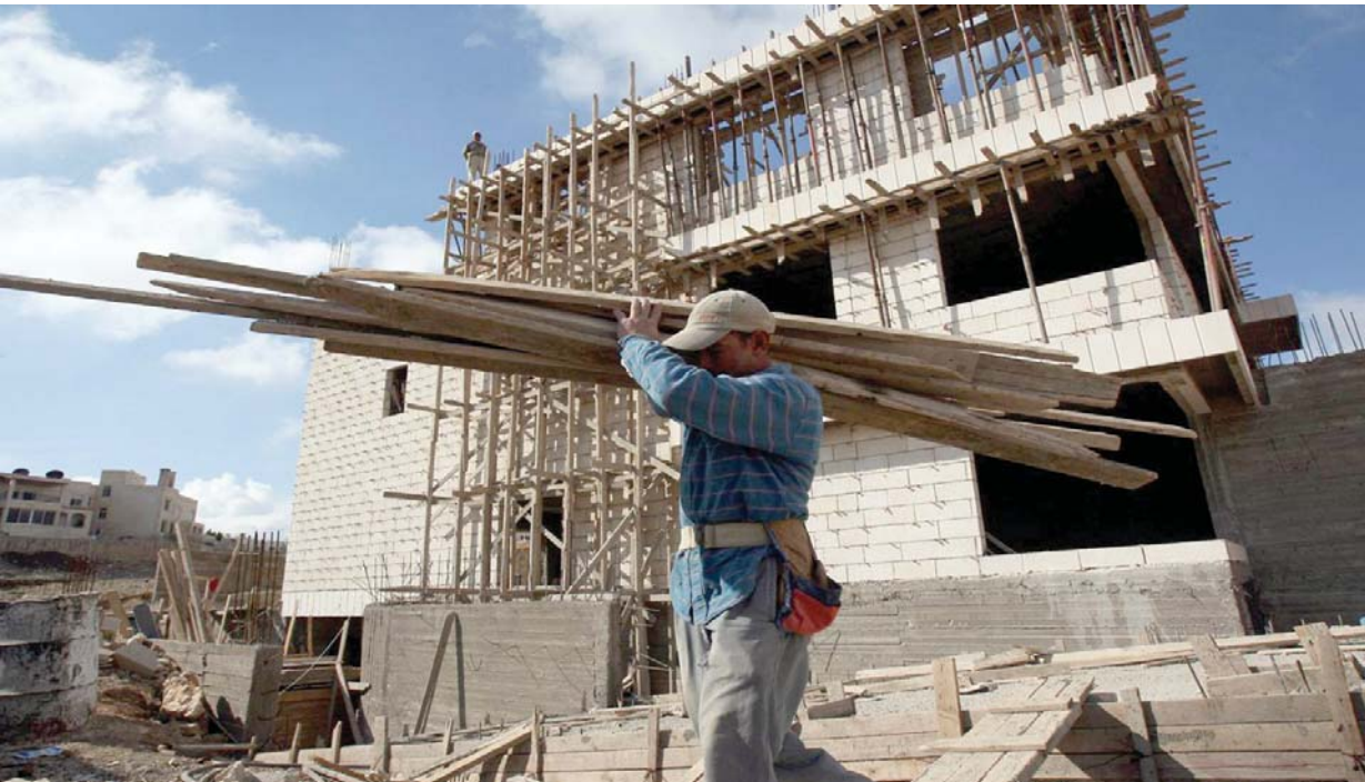
أعباء جديدة تثقل قطاع الإنشاءات
